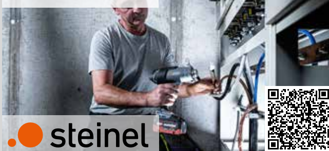
Kabel abisolieren
