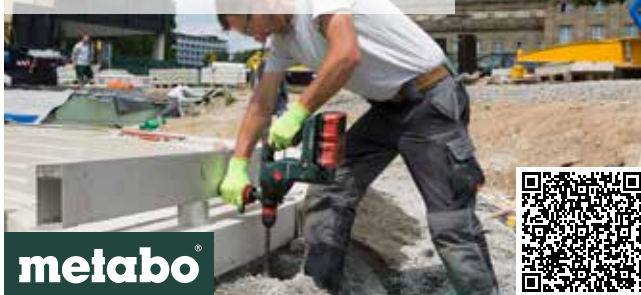
Beton bohren und meißeln
